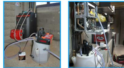
El añadido de aditivos Virax es indispensable para optimizar la acción de la bomba desenlodadora y de la bomba desincrustadora. Estos aditivos son específicos en función de la limpieza a efectuar. Su objetivo: restablecer una circulación correcta en la instalación para una mejor eficacia.
