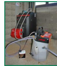
L'ajout des additifs Virax est indispensable pour optimiser l'action de la pompe à désembouer. Ces additifs sont spécifiques en fonction du nettoyage à effectuer. Leur objectif : rétablir une circulation correcte dans l'installation pour une meilleure efficacité.
