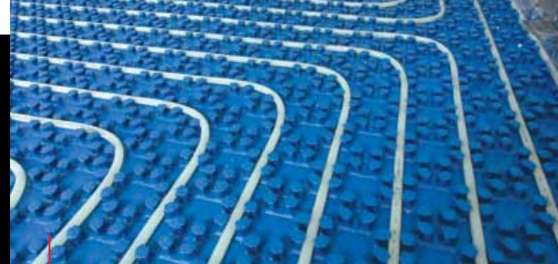
**3 Eliminare** i depositi nei sistemi di riscaldamento a pavimento per evitare le zone fredde.
